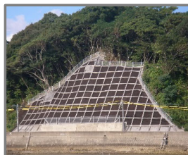
法枠・植生吹付工
