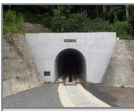
排水トンネル工
