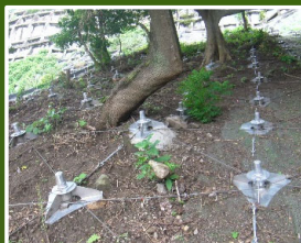
ノンフレーム工
