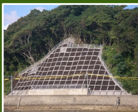
法枠・植生吹付工
