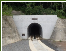
排水トンネル工
